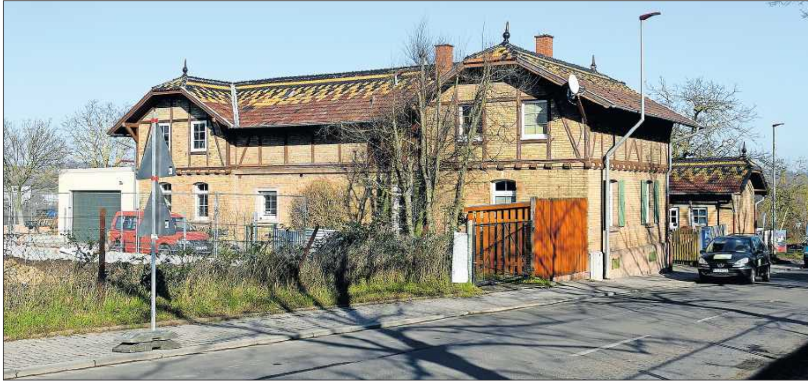
Von oben sieht das Gebäude wie ein breites „U“ aus und wird deswegen auch „Dreiseithof“ genannt.
